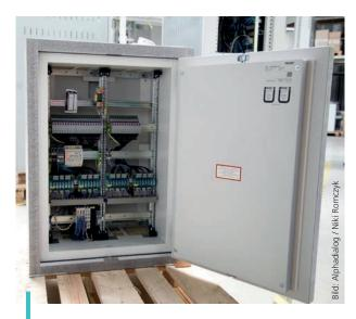
Das Setlon-System kann den Stromkreis dank innovativer Anschlusstechnik auf deutlich kleinerer Fläche zuordnen als herkömmliche Beleuchtungssysteme. Platzsparende Topjob-S-Installationsetagenklemmen von Wago machen es möglich.
