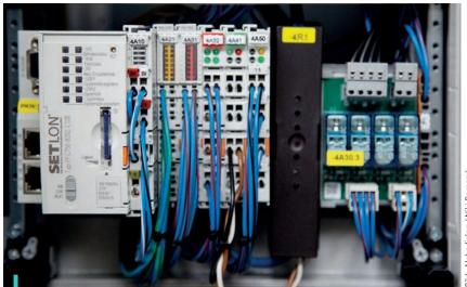
Das innovative Setlon-System ersetzt in immer mehr Gebäuden die herkömmliche Notbeleuchtung. Als Sicherheitsleuchte kann jede Leuchte verwendet werden, die dem Dali-Standard entspricht. Es werden keine zusätzlichen Bauteile in der Leuchte benötigt. Aufgrund der Eigensicherheit des Dali bleibt somit die CE-Konformität erhalten.
